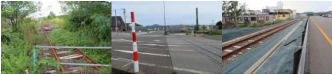
※小坂鉄道跡、手こぎトロッコ線路
